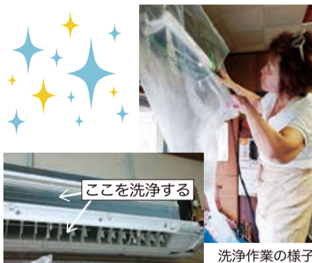
洗浄作業の様子
